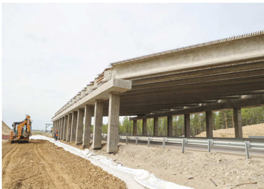
Строительство обхода города Усолья-Сибирского
